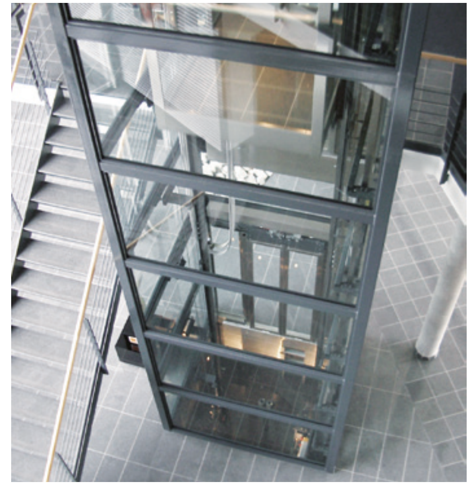
Estrutura da caixa em tubo quadrado Envidraçada entre os perfis
