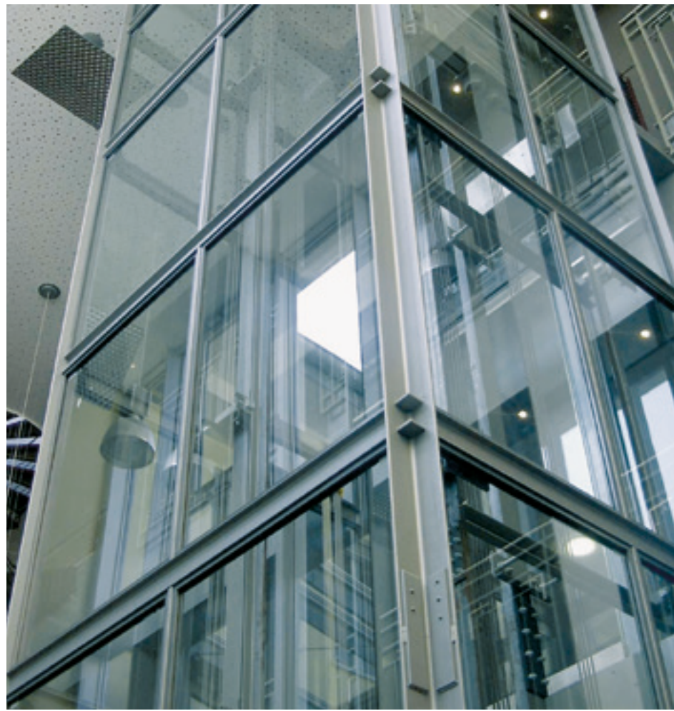
Estrutura da caixa em cantoneira Cantoneira aberta para o exterior
