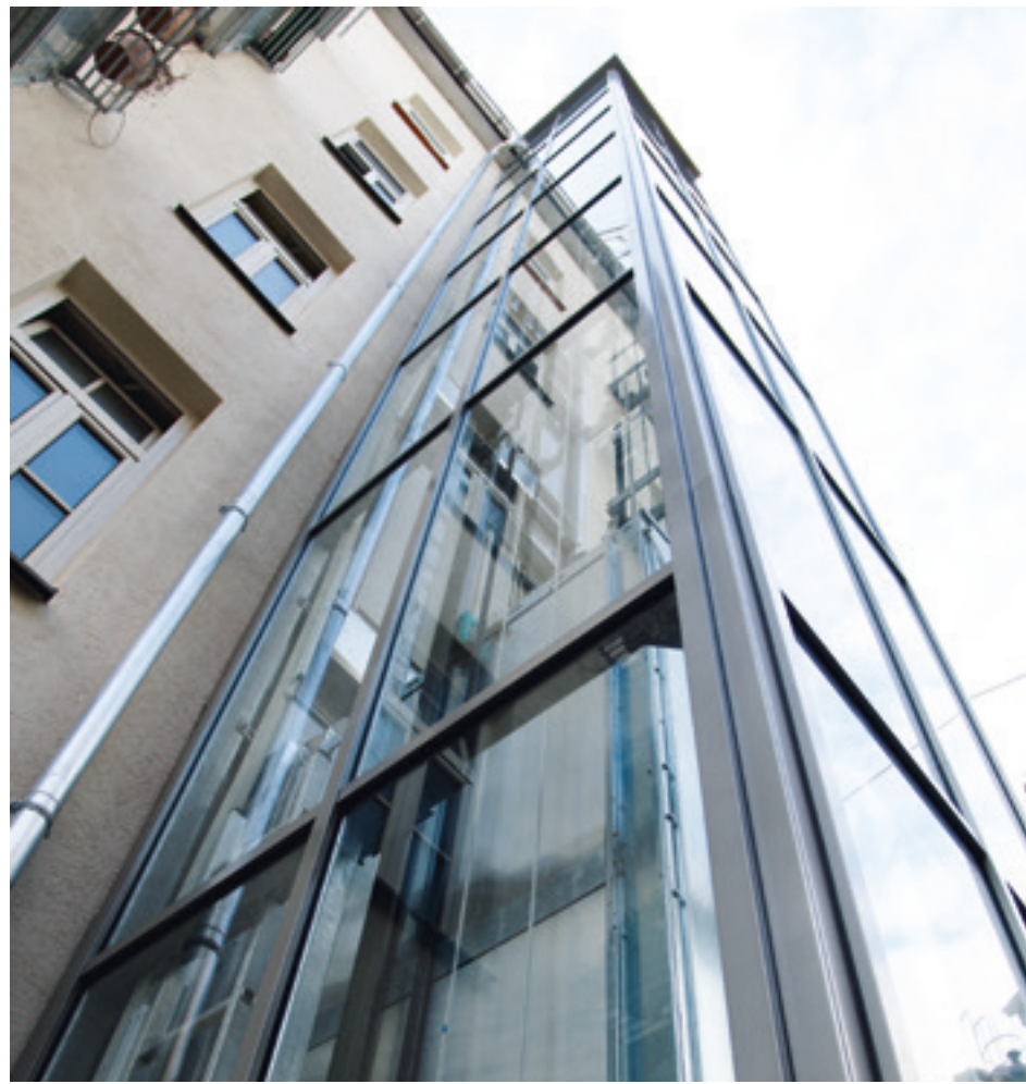
Estrutura da caixa em tubo quadrado Revestimento em vidro com perfis em alumínio
